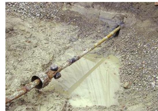
1. März 2007 – Der erste Aufweitkopf mit einem Durchmesser von 355 mm ist am Bohrgestänge montiert, und zur Abfahrt in Richtung Stockhornstrasse bereit.
